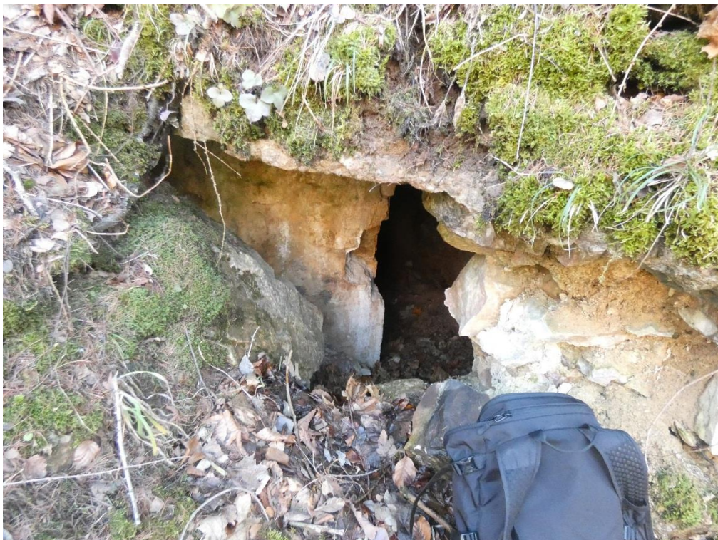
Fot. 10 Wejście do nieczynnej sztolni w kamieniołomie pod miejscowością Mysłów
