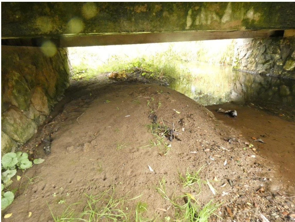
Fot. 8 Widok na teren pod przepustem na rzece Kaczawa
